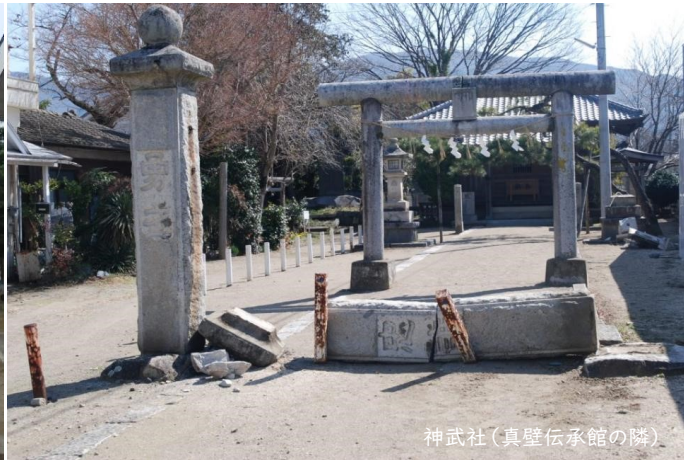
神武社(真壁伝承館の隣) 地震翌日 手前の石塔と奥の燈籠の右側は倒れているが、左側は倒れていない。このような倒れないラインもあった。
