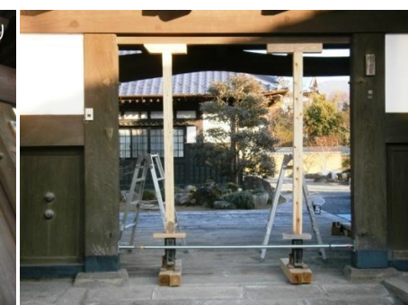
ジャッキアップにより、柱の位置を修正した。
