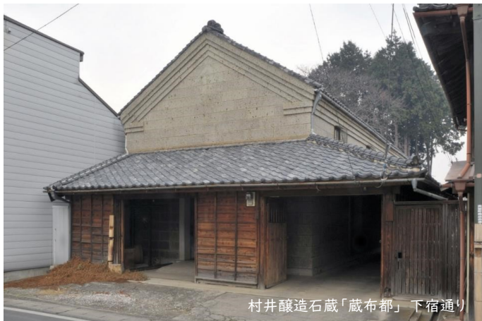
村井醸造石蔵「蔵布都」下宿通り 地震前 大谷石(凝灰岩)の石蔵は大正時代に多く建てられた。
