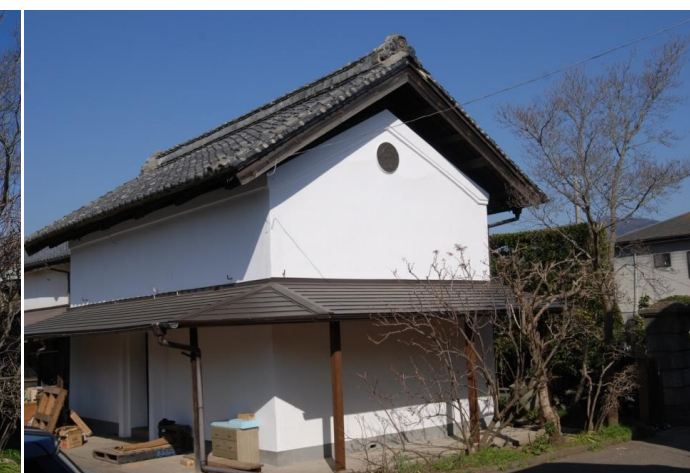
壁工事竣工 土や耐震壁で修理。後日、屋根工事も実施した。
