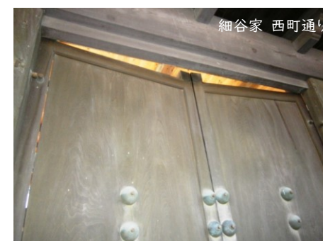
地震で柱がずれ、長屋門の門扉にずれが生じた。
